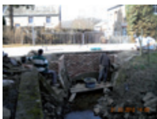
Réfection du pont de la rue Léon Pirsoul
